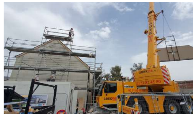
ASSEMBLAGE SUR SITE DES ÉLÉMENTS PRÉFABRIQUÉS
