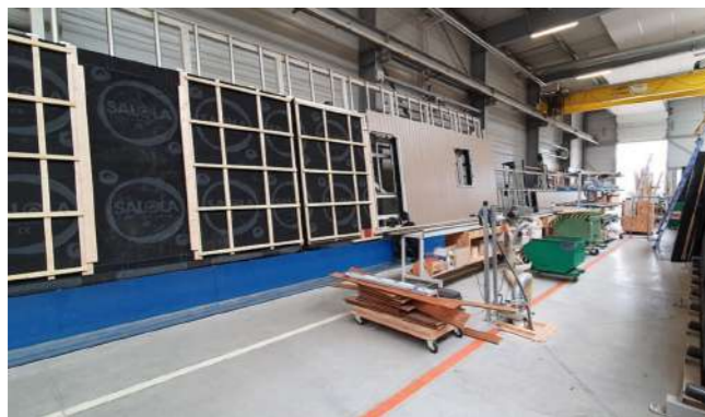
CONCEPTION EN ATELIER DES PANNEAUX INTÉGRANT ISOLATION, FENÊTRES & BARDAGES BOIS
