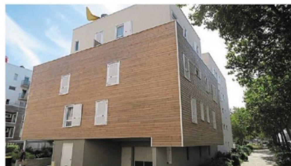
Les locataires de l'immeuble du square Delzieux avaient de gros problèmes de chaudière.
