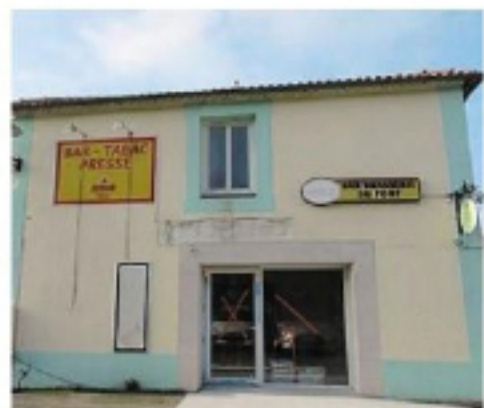
A Saint-Même-le-Tenu, l'ouverture, après aménagements, du Café du Port est très attendue. | CREDIT PHOTO : QUEST FRANCE
