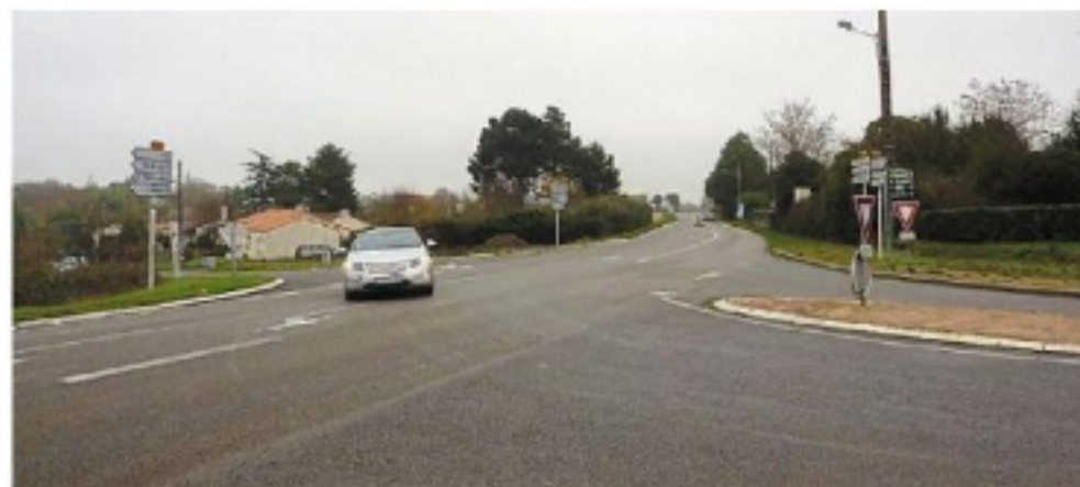
A Messan, sur la RD 723, à Rouans, l'aménagement d'un rond-point est très attendu. | CREDIT PHOTO : QUEST FRANCE
